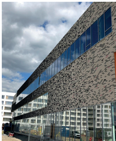
Chantier à Gif sur Yvette
