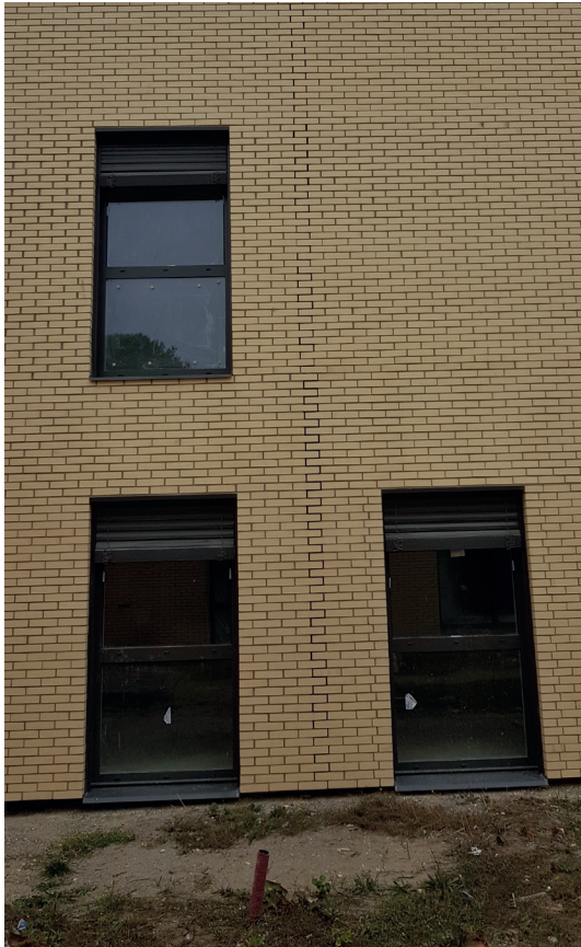
Joint de fractionnement croisé
