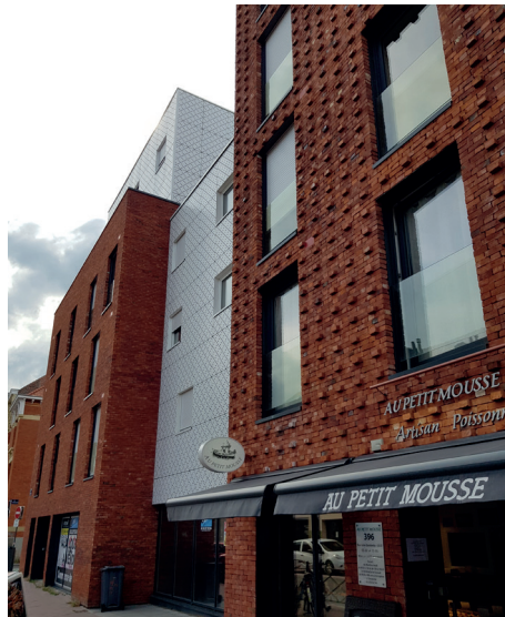
Chantier à Lille
