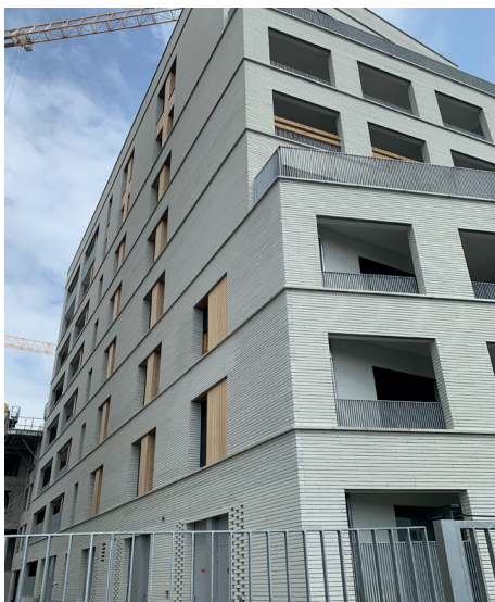
Chantier à Saint Denis
