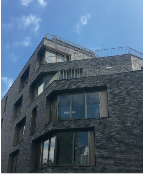
Chantier à Paris 11
