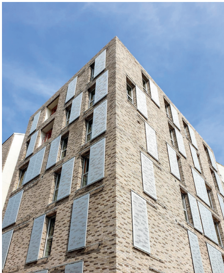
Chantier à Saint Denis
