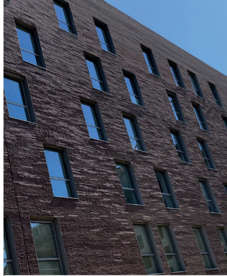
Chantier à Achères
